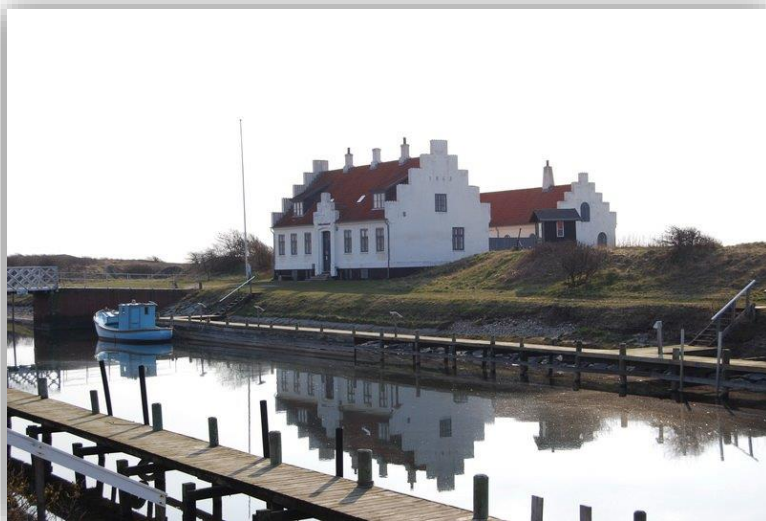
Kanalhusene ved Løgstør kanal
